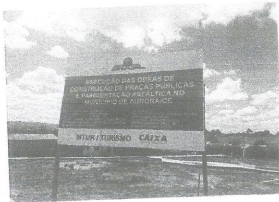
Foto 01 – Placa de Obra dos Serviços de Fiscalização no município de Aurora-Ce
