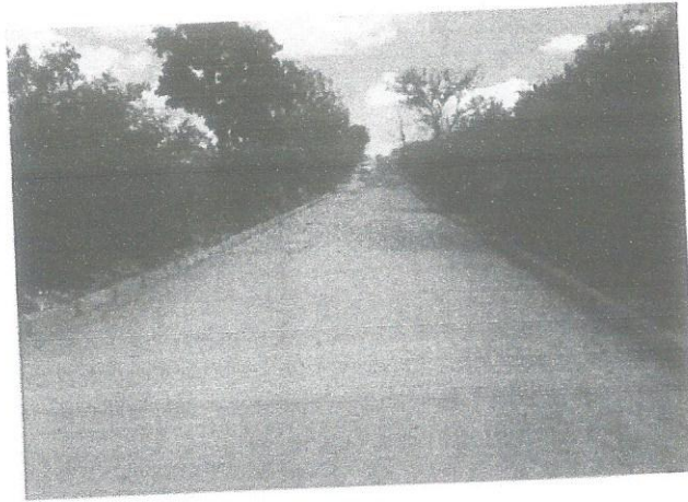
Foto 03 – Serviços de Acompanhamento, Consultoria e Fiscalização dos Serviços de Pavimentação em Pedra Tosca da Ladeira do Pavão no município de Aurora-Ce.
